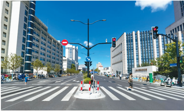
铜川路(真北路-岚皋路)改建、架空线入地及合杆整治工程
