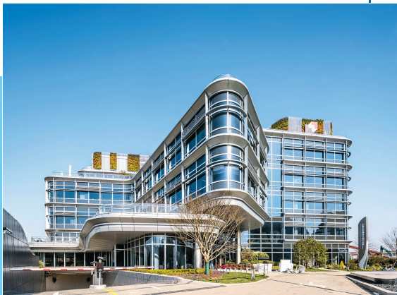
长三角一体化绿色科技示范楼
