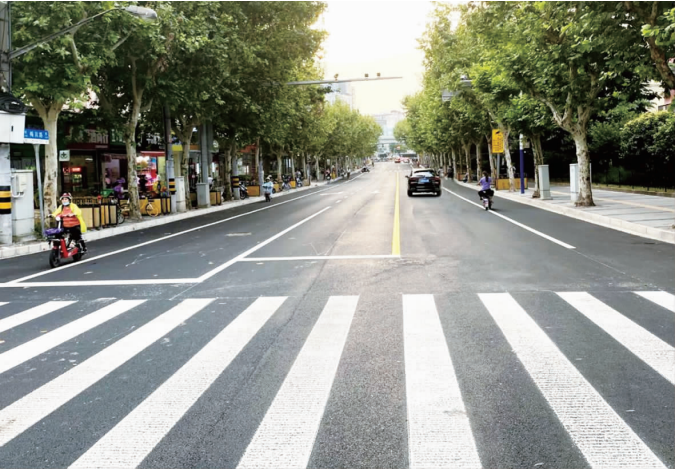
施工改造后的梅川路
